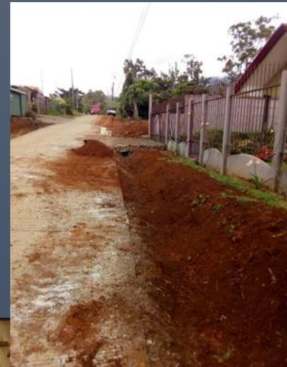
**BARRIO LAS BRISAS LA SABANA, SE REALIZÓ CAMBIO DE TUBERÍA DE 1 ½" EN UN TRAMO DE 492 METROS**
